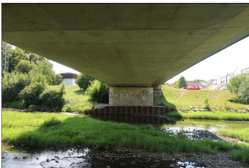
podhled NK od P2
