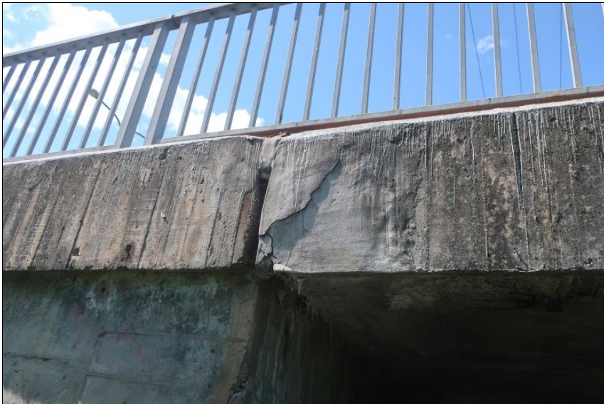
separace sanace levé římsy nad O4
