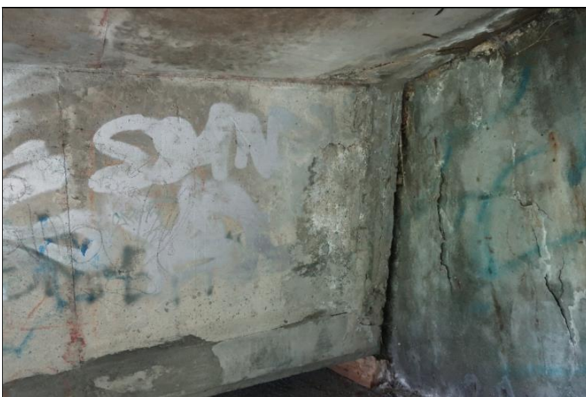
separace krycí vrstvy na levém boku NK nad O1
