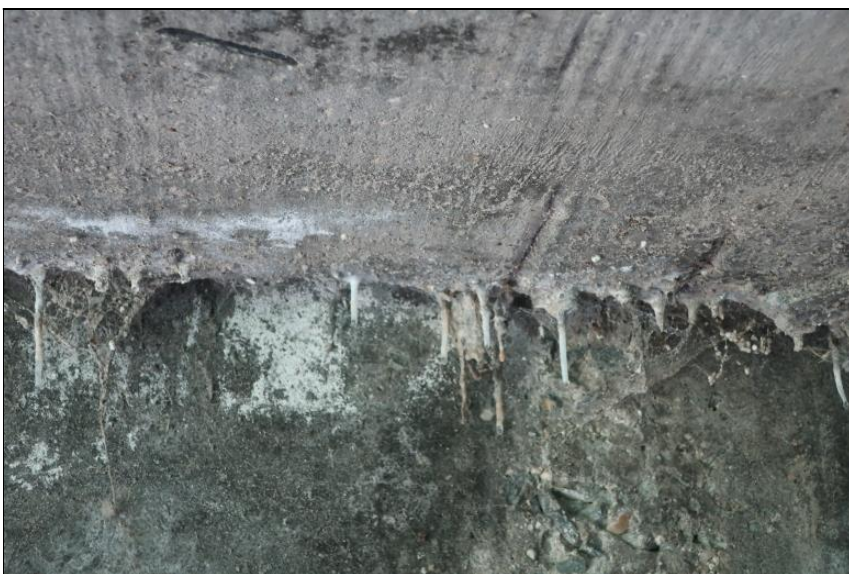
stopy po průsaku s výluhy pojiva na spodním líci levé konzoly pod MZ O4
