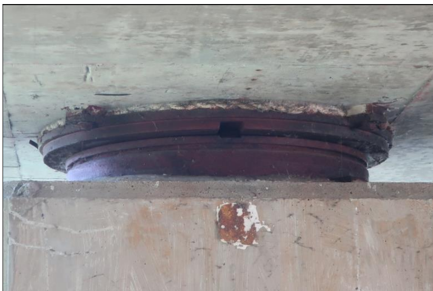
levé ložisko P2
