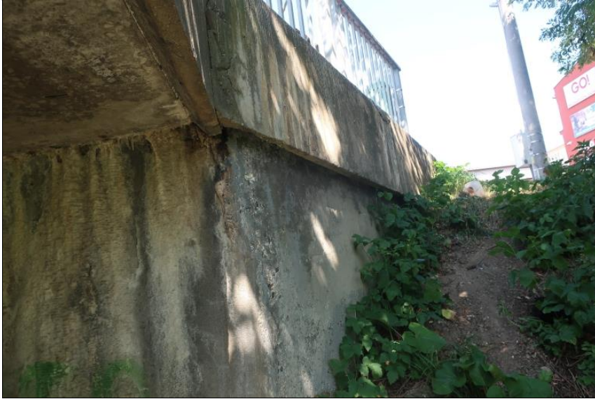
levé křídlo O1
