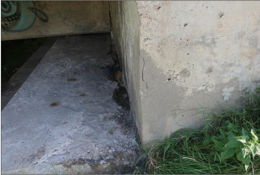
separace sanace v pravé části ZZ O4
