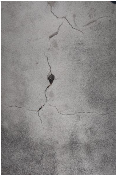
nepravidelné trhliny v krytu chodníku
