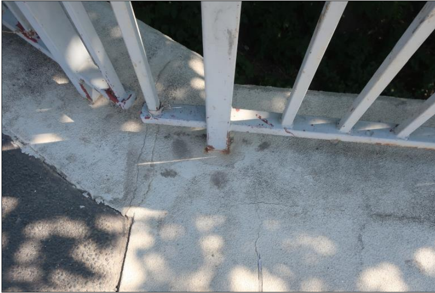
nepravidelné trhliny v krytu chodníku
