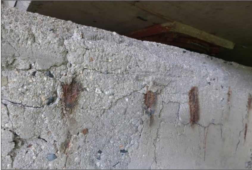
detail poruch v hraně ÚP O1
