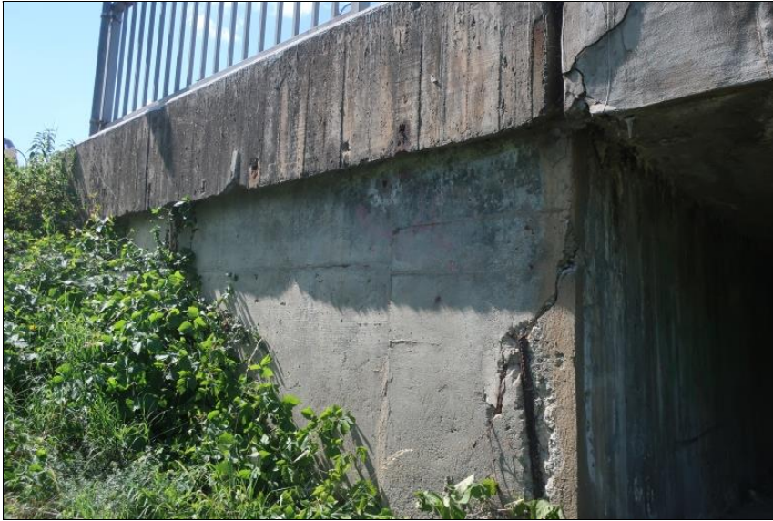
levé křídlo O4
