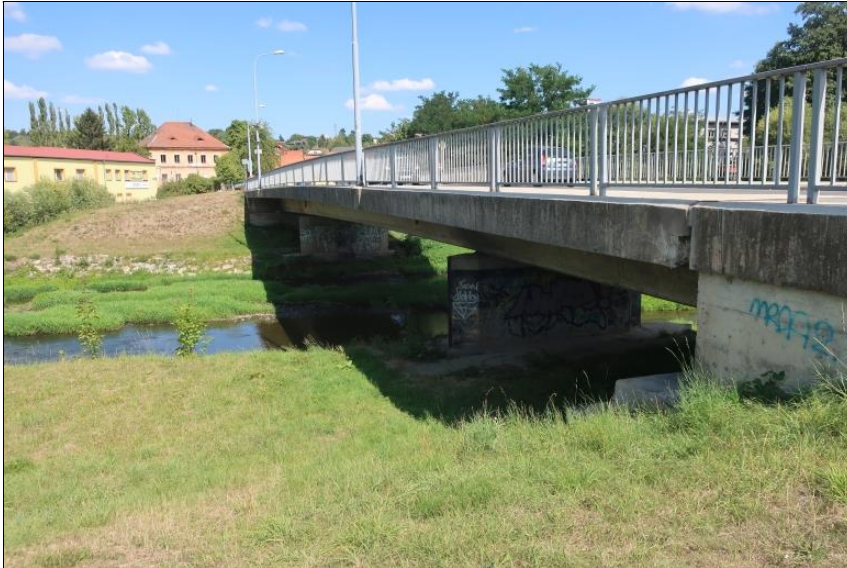
pravý bok mostu od O4
