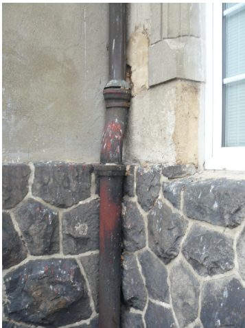
Detail poškození omítky u dešťového svodu
