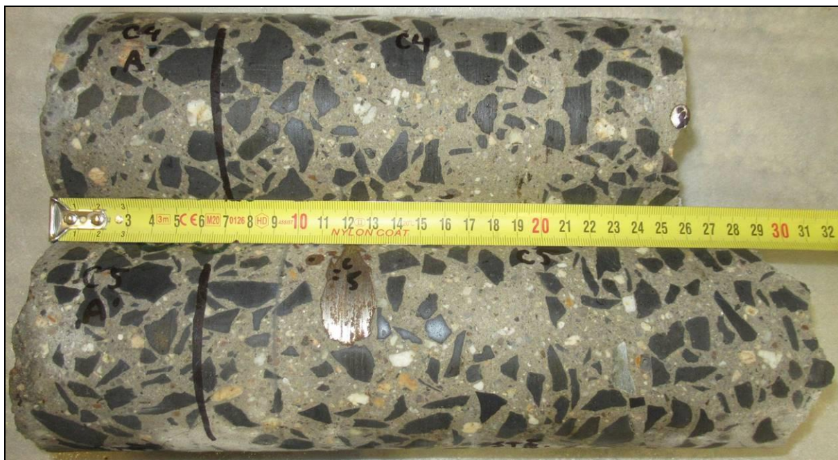
Foto 8: Pohled na vývrty C4 a C5
