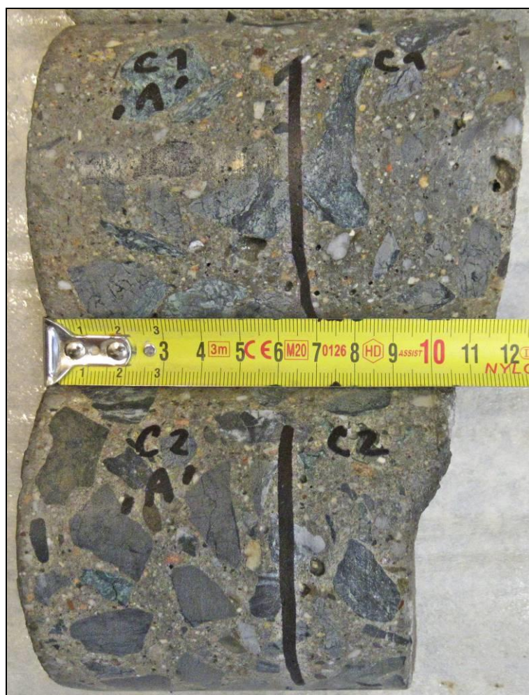
Foto 7: Pohled na vývrty C1 a C2
