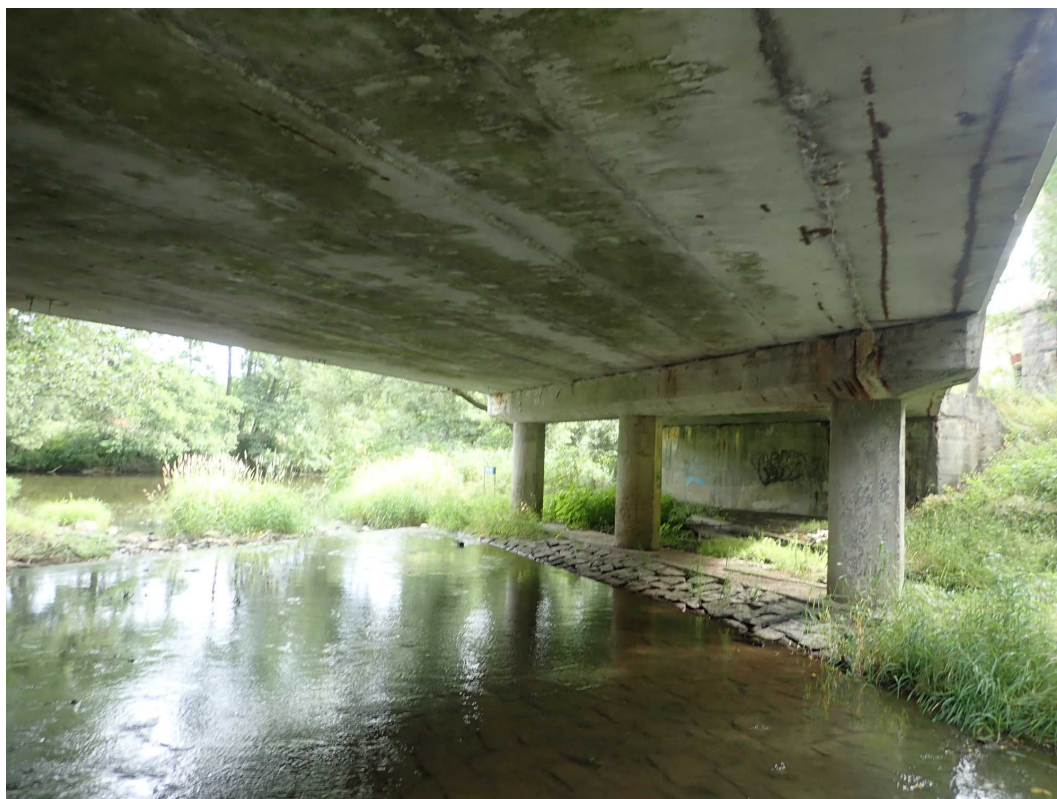
Obrázek 2 Podhled NK mostu v poli 2
