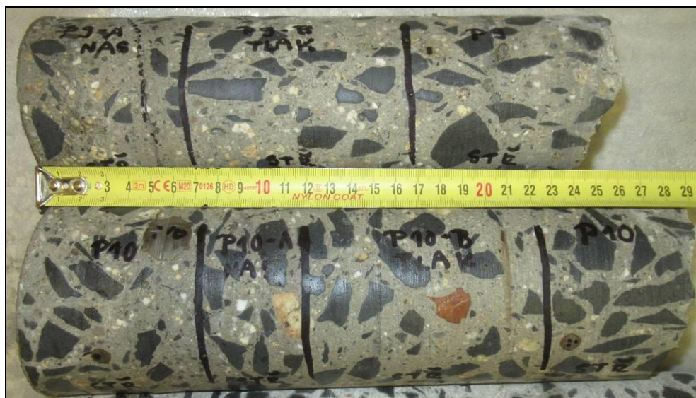
Foto 5: Pohled na vývrty P9 a P10
