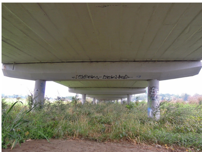
Uložení nosné konstrukce na pilíř.
