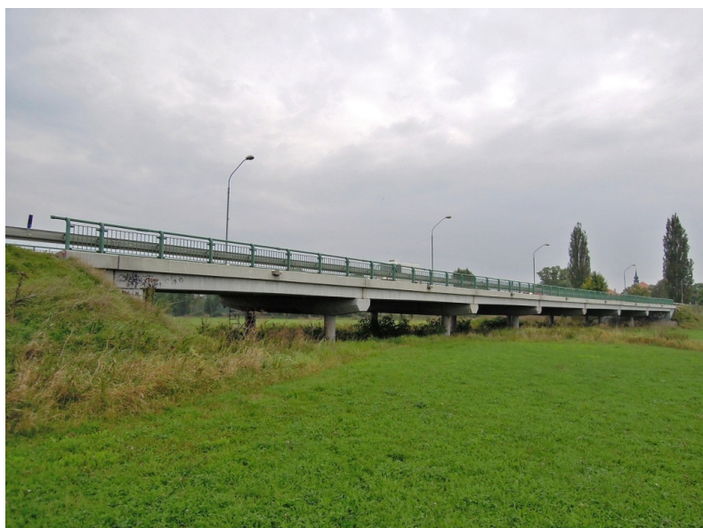
Pohled na most – levá strana.
