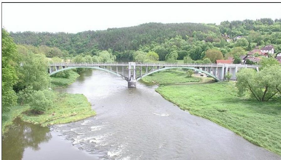
Levá strana mostu
