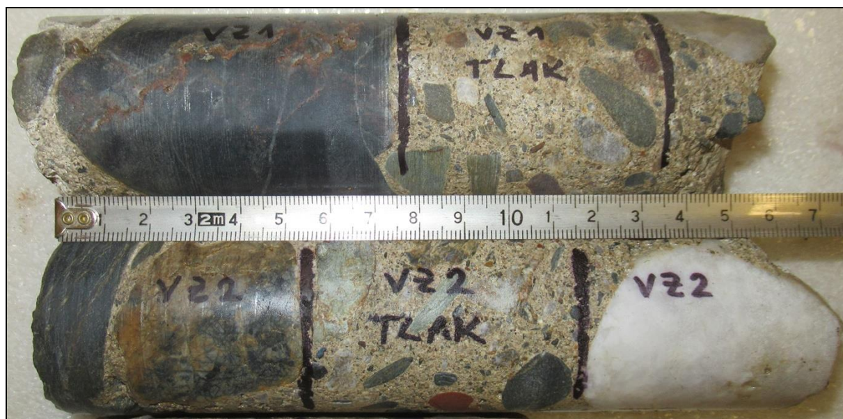
Foto 14: Pohled na vývrty Vz1 a Vz2
