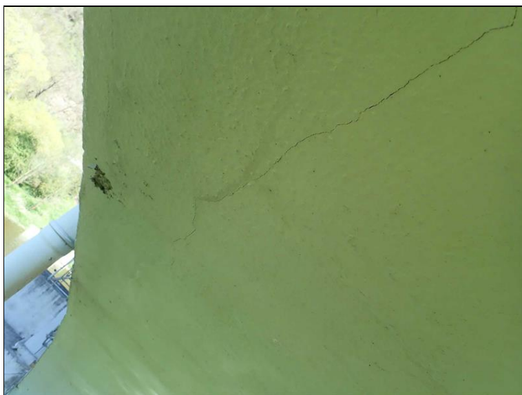
Trhlina v dolním líci oblouku.
