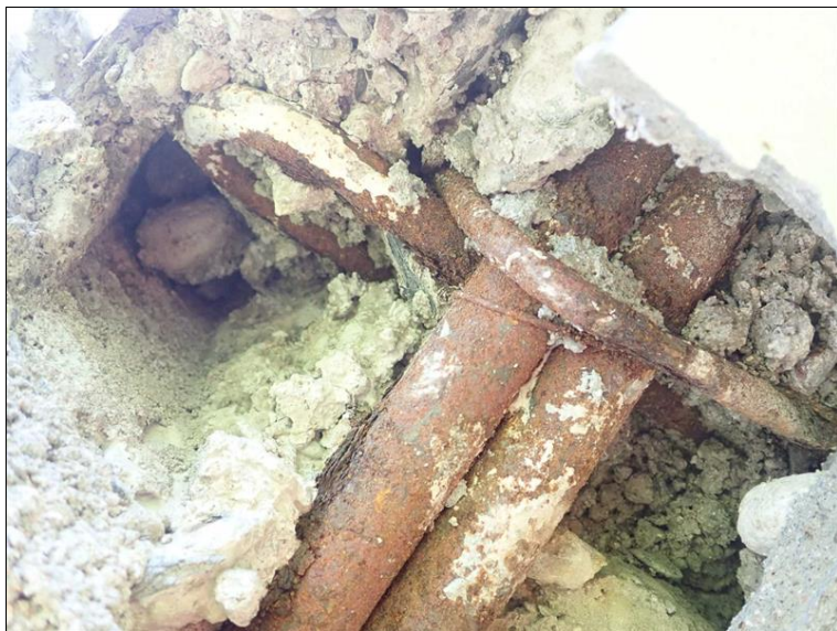
Odpadlé krytí na dolním líci oblouků je často způsobeno neprobetonováním.
