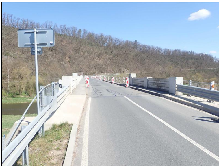
Pohled na most po směru staničení.
