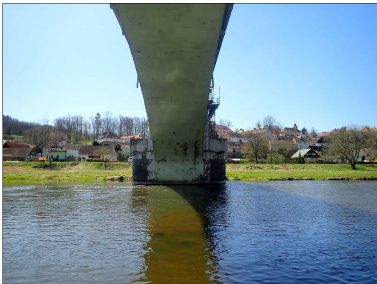
Podhled NK, pohled na P4.
