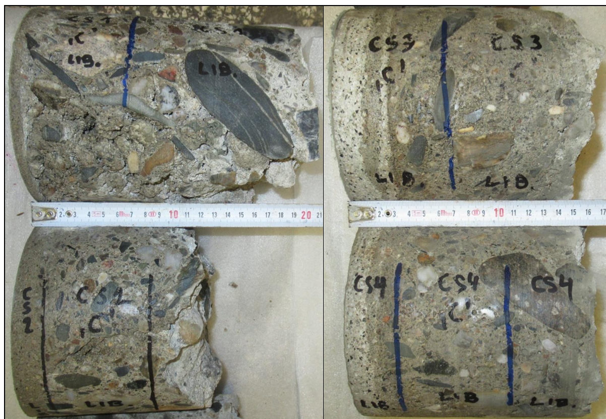
Foto 13: Pohled na vývrty Cs1 až Cs4
