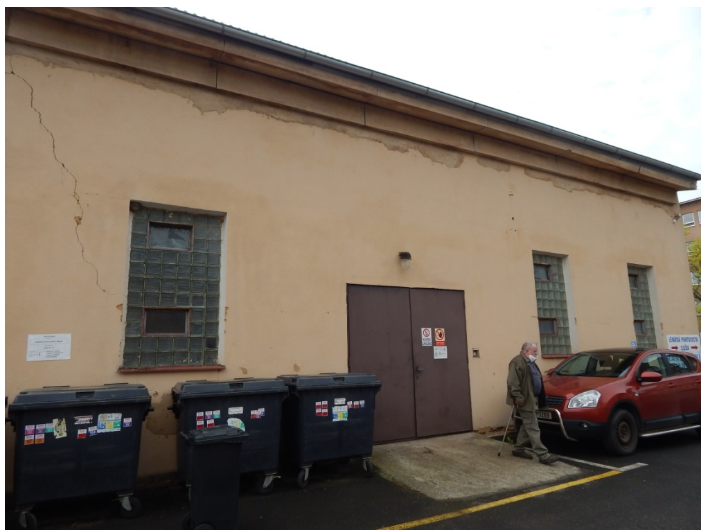
16. Jižní pohled na původní PS
