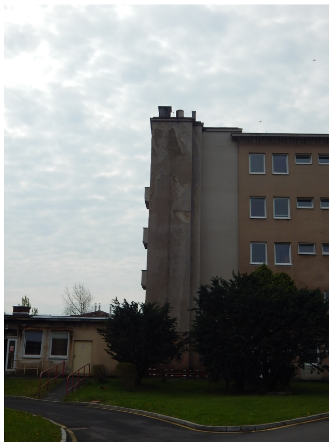
13., 14. Pohled na objekt lůžkové části s komínem
