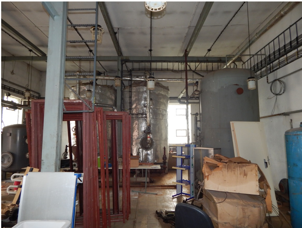
18. Parní zásobníkové ohřivače TUV v původní PS
