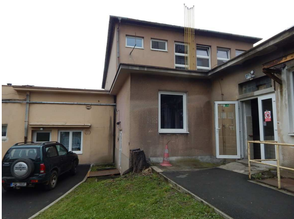
12. Západní pohled na objekt stávající kotelny
