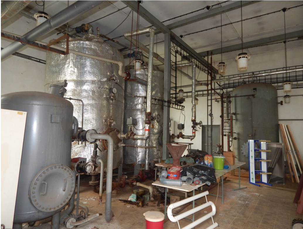
17. Parní zásobníkové ohřivače TUV v původní PS
