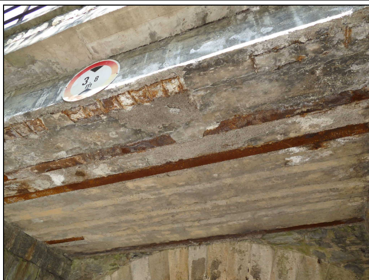
Foto č. 2 – Konstrukce K 01 – popraskaný a vydrolená beton z pohledu konstrukce
