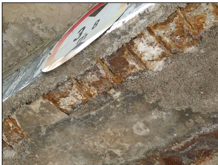
Foto č. 3 – Konstrukce K 01 – obnažené příruby nosníků s korozí
