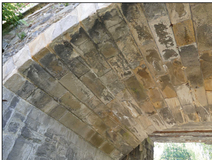
Foto č. 4 – Konstrukce K 02 – úložná spára nad O 02, průsaky vody s výluhy pojiva
