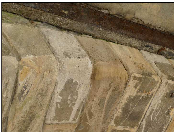
Foto č. 6 – Konstrukce K 02 – věnec vlevo, zvětralé kameny
