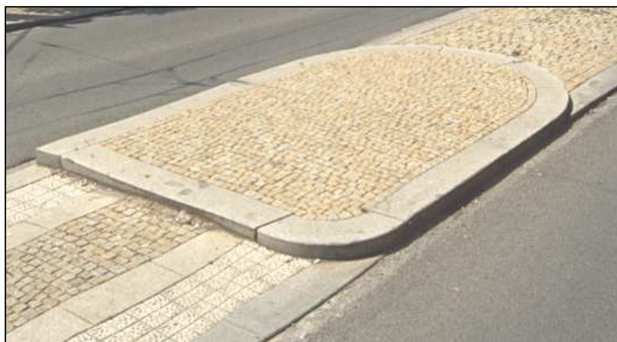
Obr. 1 – Zaoblení silniční obruby ochranného ostrůvku ve směru jízdy
