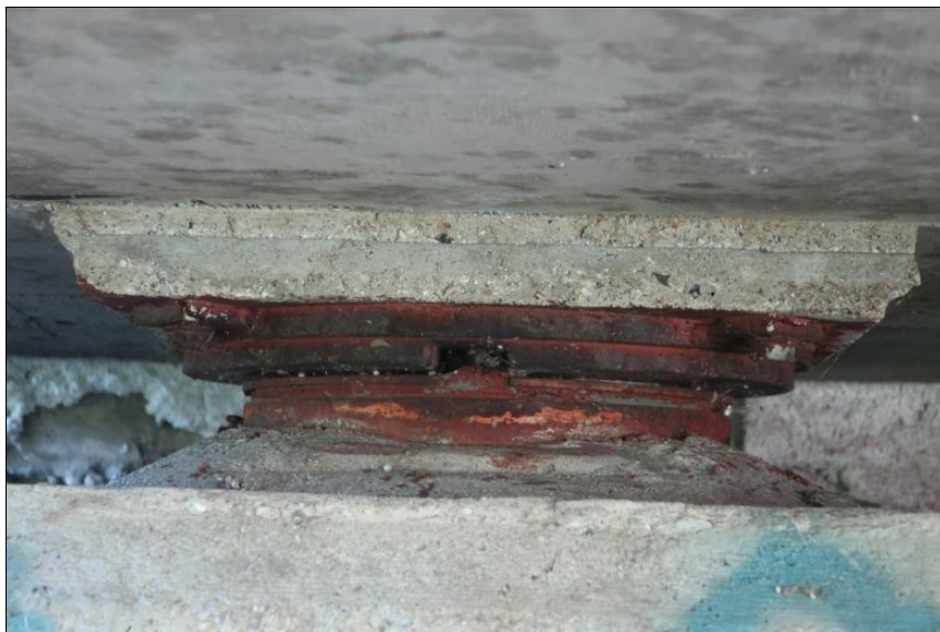
levé ložisko O4
