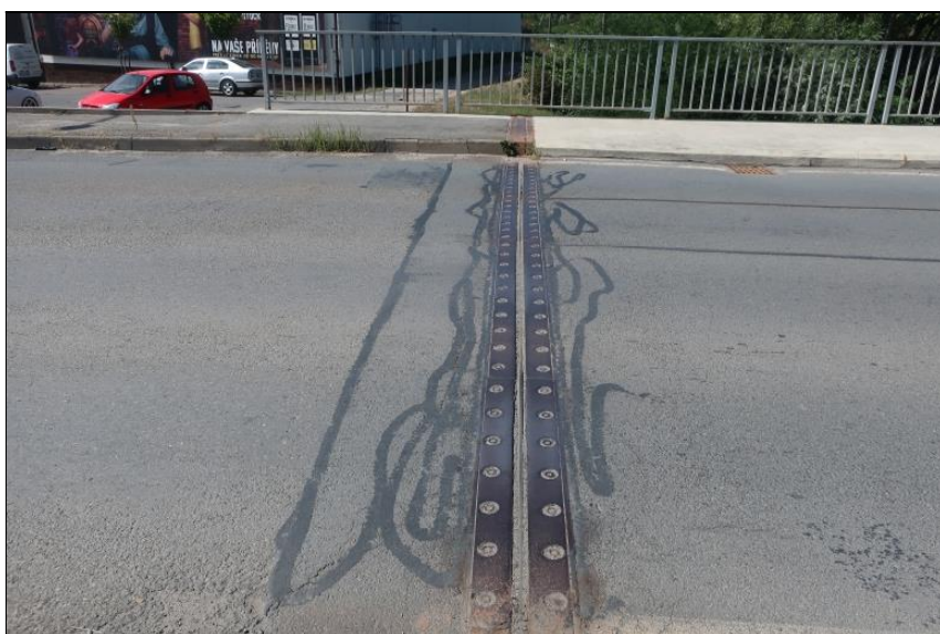
MZ O4 v oblasti vozovky
