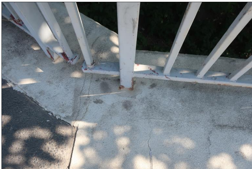
nepravidelné trhliny v krytu chodníku
