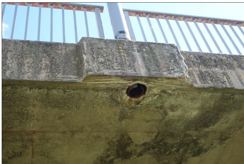
mrazový rozpad betonu pravé konzoly v místě vetknutí sloupu VO u P3
