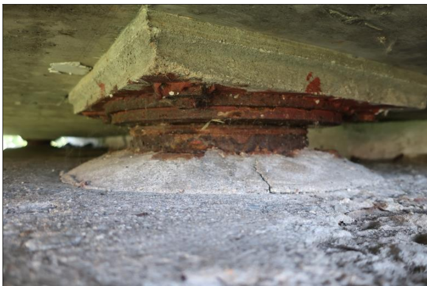
pravé ložisko O4 oříčná trhлина v podkladním bloku
