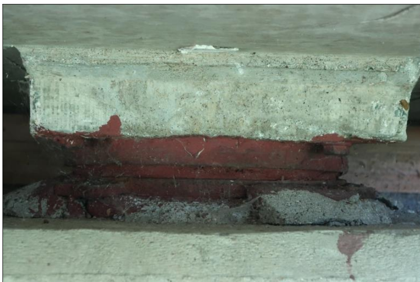
levé ložisko O1
