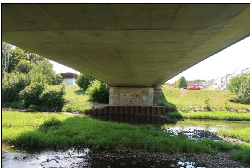
podhled NK od P2
