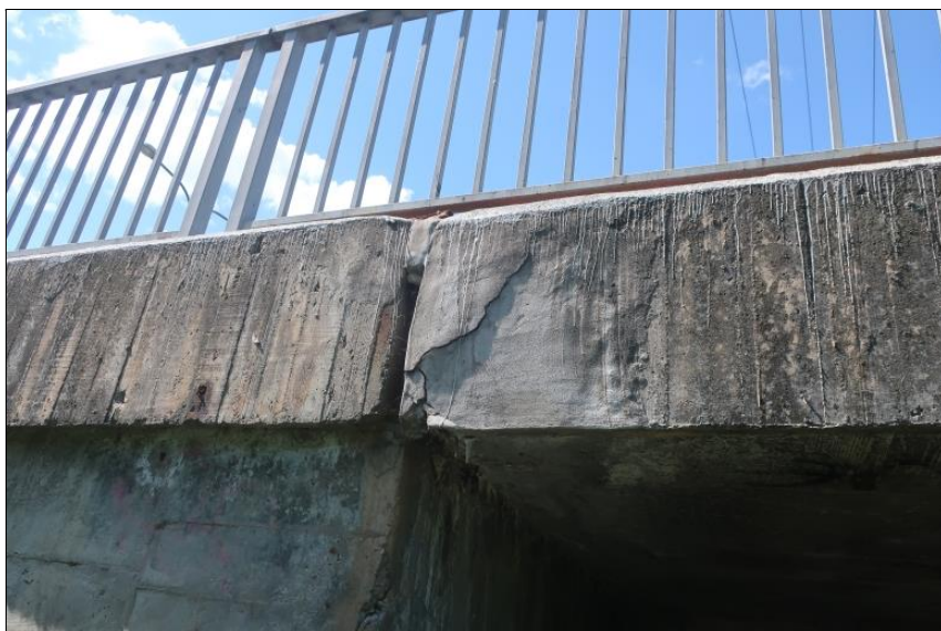
separace sanace levé římsy nad O4
