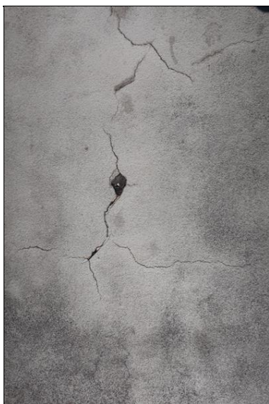
nepravidelné trhliny v krytu chodníku
