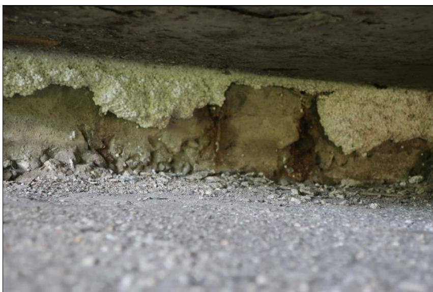
obnažená korodující výztuž v oblasti vetknutí závěrné zídky do úložného prahu u O4
