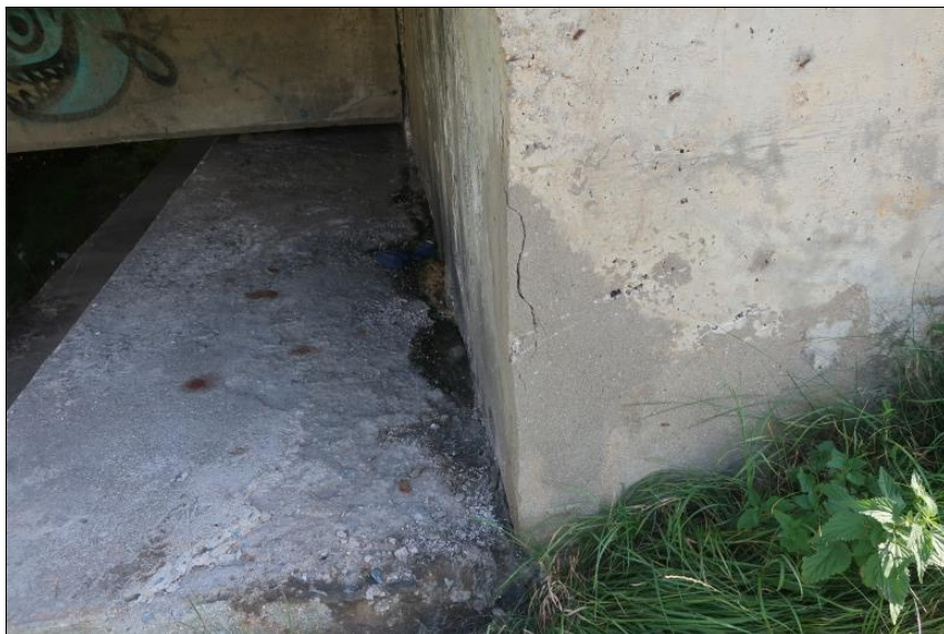
separace sanace v pravé části ZZ O4
